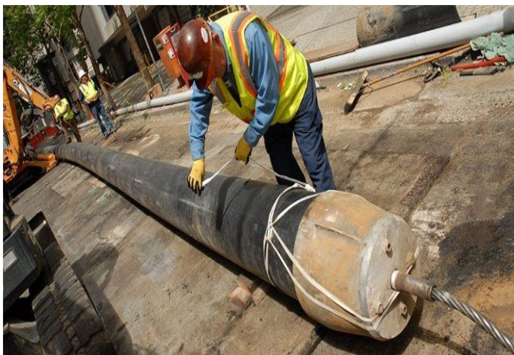
16 Сурет-Құбырларды траншеясыз төсеу арқылы су құбырын жүргізу
